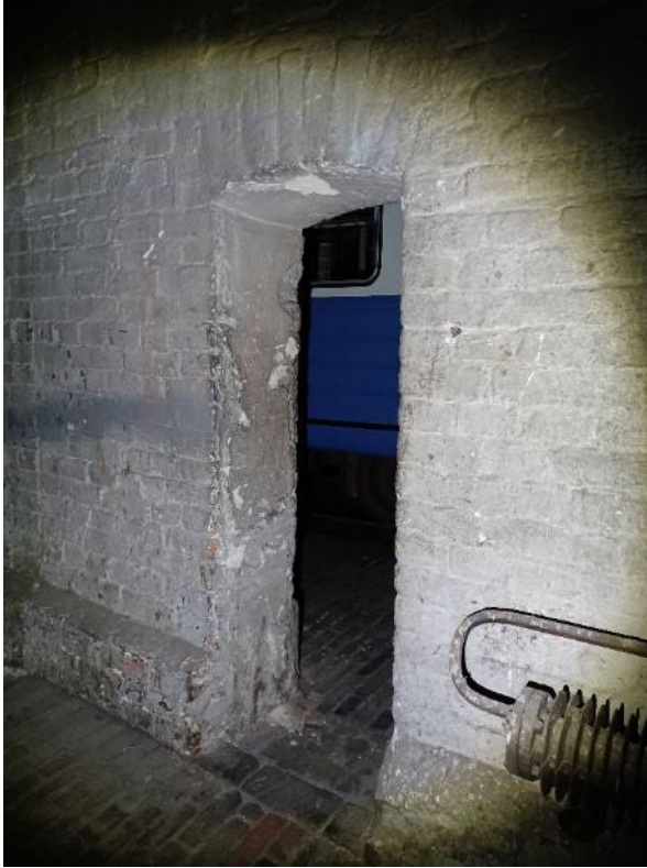
Kuva 89. Tila nro 8. Viereiseen pilttuuseen kuljetaan kapeasta oviaukosta (18). Seinässä näkyy umpeen muurattuja aukkoja useassa eri kohdassa.
