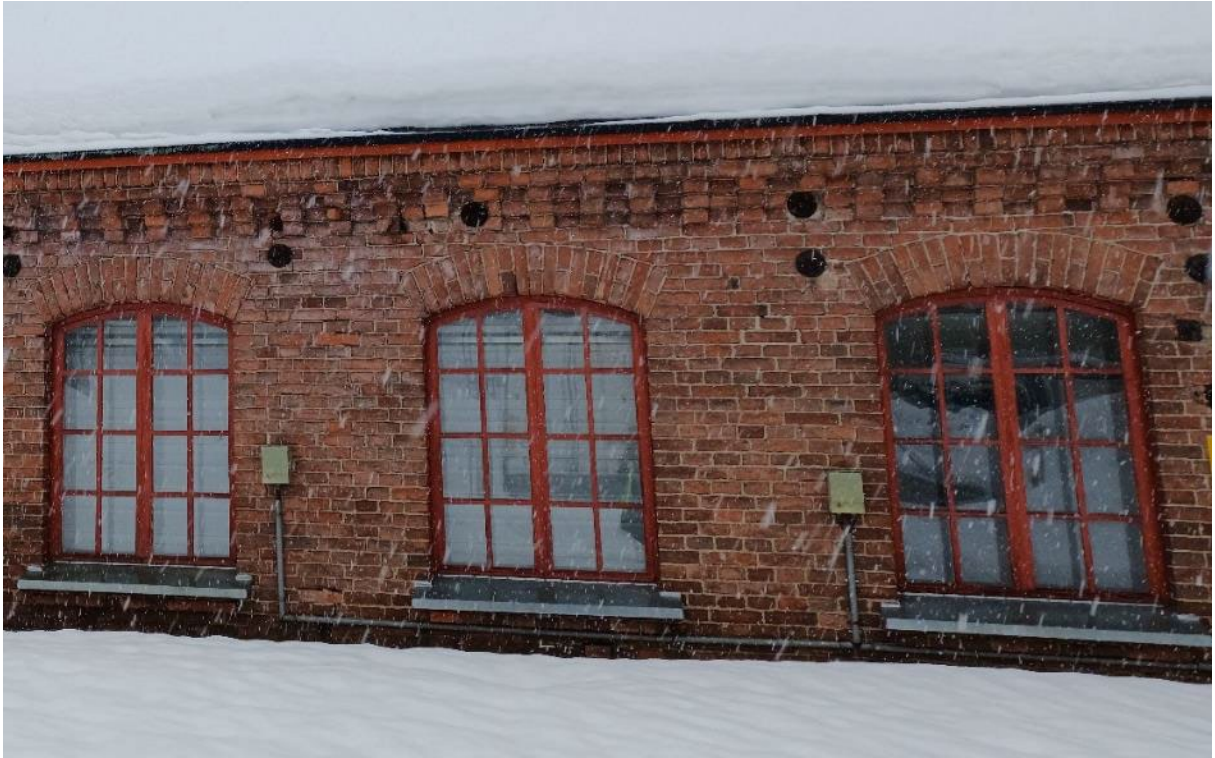
Kuva 58. Toimistopäädyn ikkunat etelän suuntaan.
