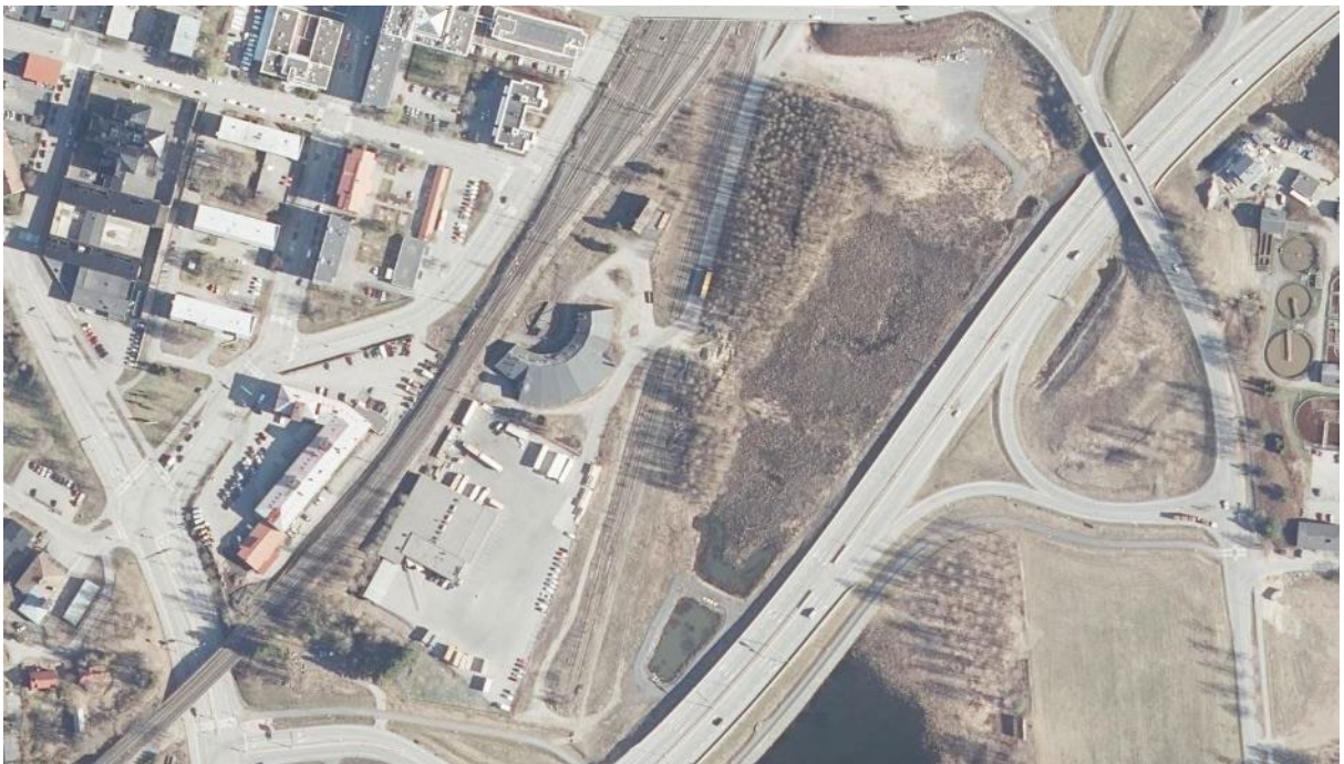
Kuva 21. Veturitalli ympäristöineen ilmakuvassa. Lähde: Maanmittauslaitos. Paikkatietoikkuna.
