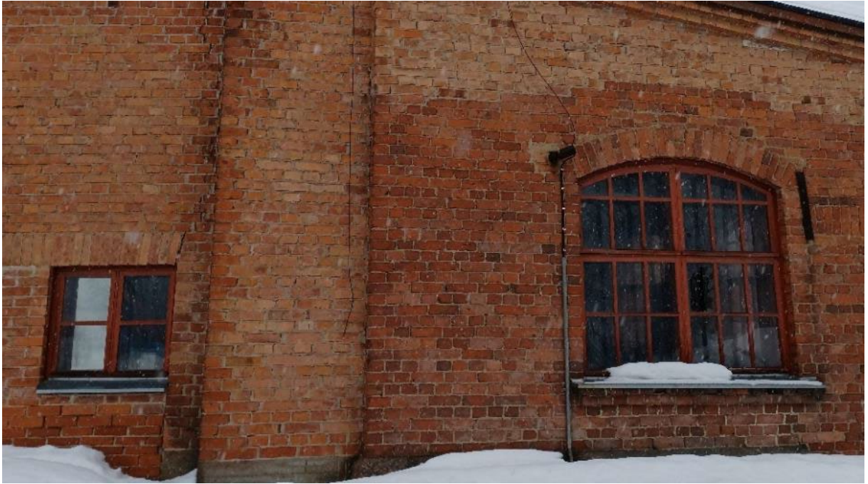
Kuva 60. Entisen polttoainevaraston ja pannuhuoneen ikkunat.
