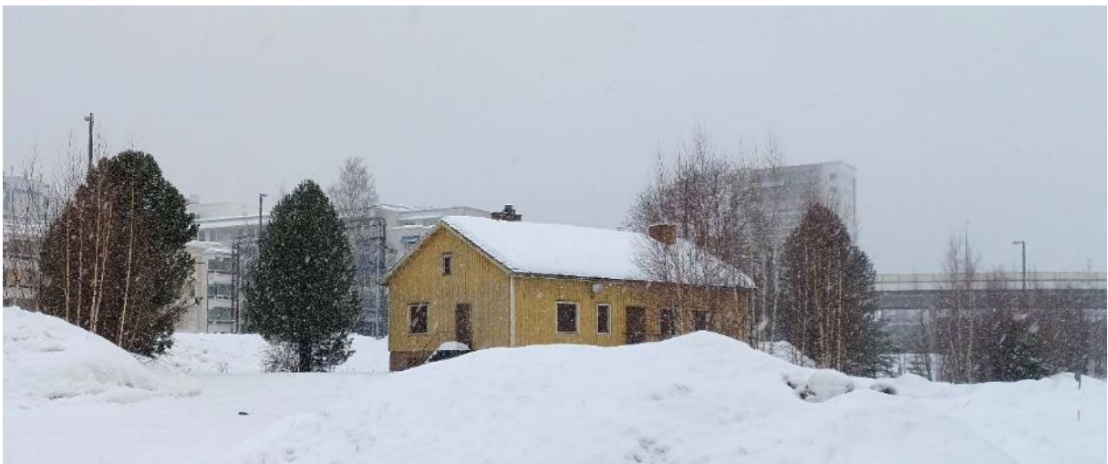
Kuva 23. Entinen huoltorakennus veturitallien pohjoispuolella.
