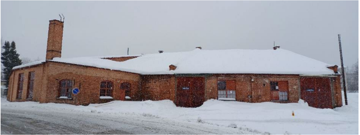
Kuva 33. Rakennuksen idänpuoleinen julkisivu.
