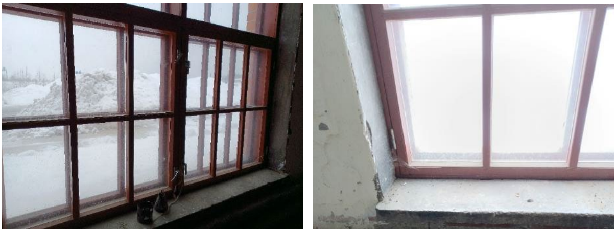
Kuva 99. Ikkunat ovat uusitut. Vain alimmaisissa puitteissa on 6-ruutuinen jako.
