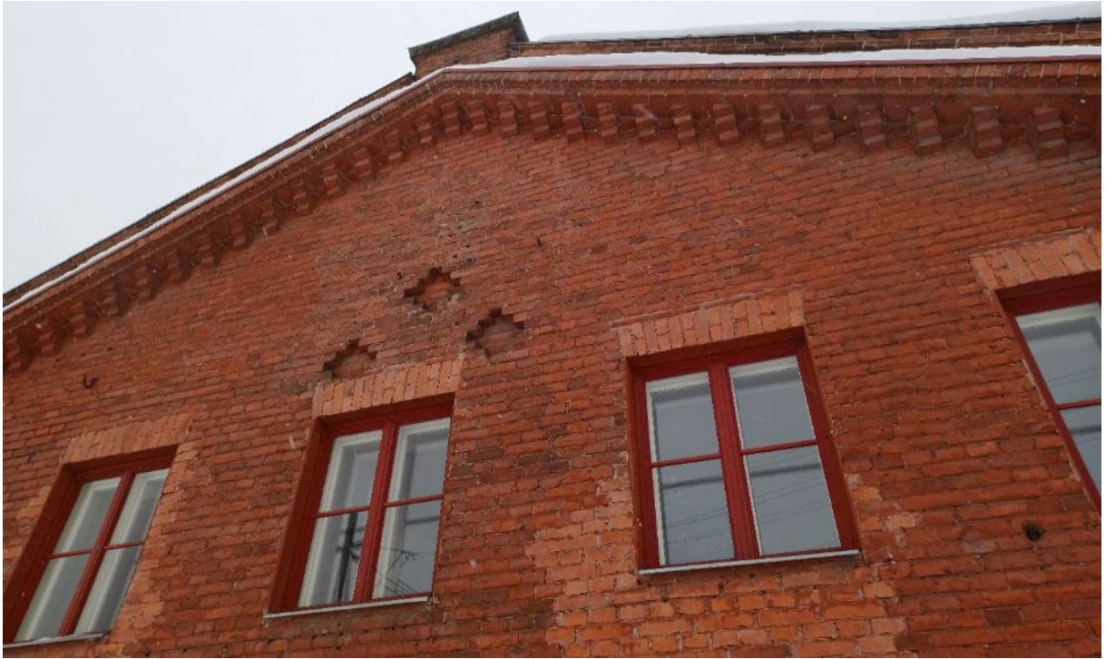
Kuva 56. Toimistopäädyn ikkunoita länteen päin.
