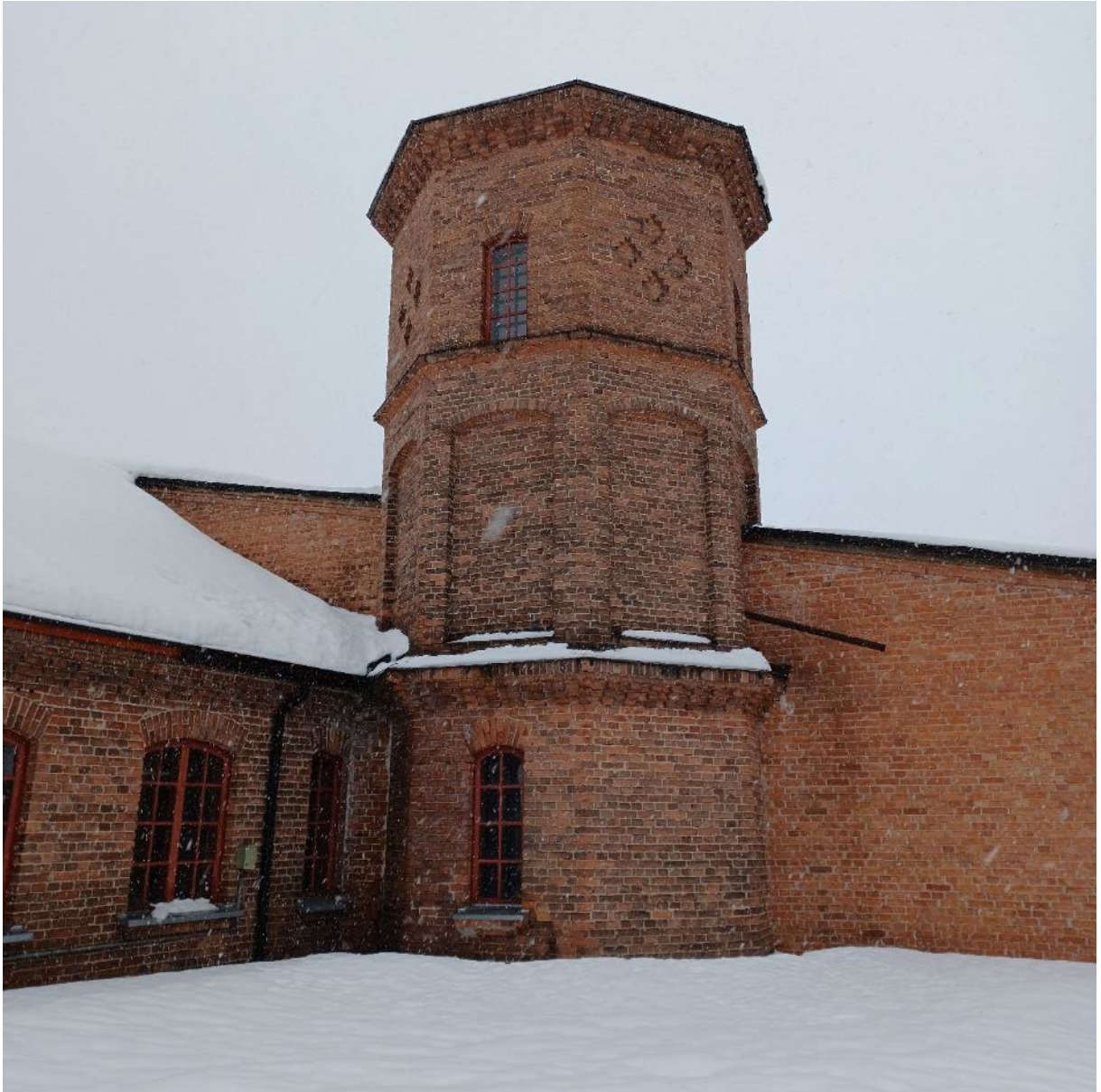
Kuva 41. Vesitorni vuodelta 1889 kuuluu rakennukseen vanhimpiin osiin (tila nro 10). 1940-luvulla tehty laajennusosa erottuu julkisivussa vaaleampana ja niukemmin koristeltuna.
