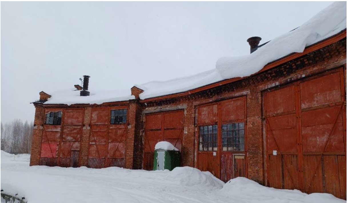
Kuva 34. Sisäpihaa kääntöpöydän vierestä kuvattuna. Rakennuksen pohjoispäädyn tilat 1-4.
