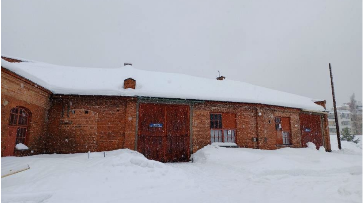
Kuva 46. Oikealla arviolta 1908–1913 rakennetut pilttuut (tila 1) ja vasemmalla osia vuodelta 1908. Umpeen muuratun ikkunan takana on ollut öljysäiliö.
