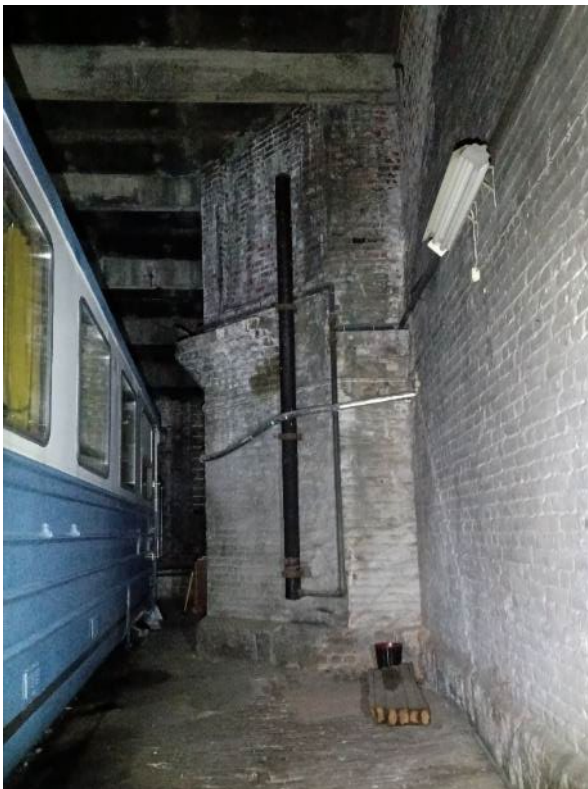
Kuva 90. Tilan 8 seinäpintaa, edessä vesitorni.
