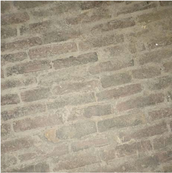
Kuva 75. Lattia on ladottu punatiilistä.
