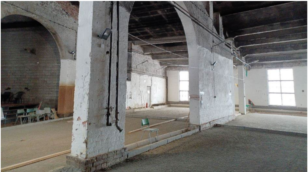
Kuva 97. Pilttuiden lattiapinnat on päällystetty hiekalla.
