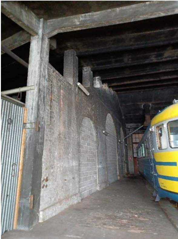
Kuva 93. Tila 6. Väliseinän kolme suurta holvikaarta on muurattu umpeen kevytbetoniarkoin, mutta yhteen on jätetty kulkuaukko.
