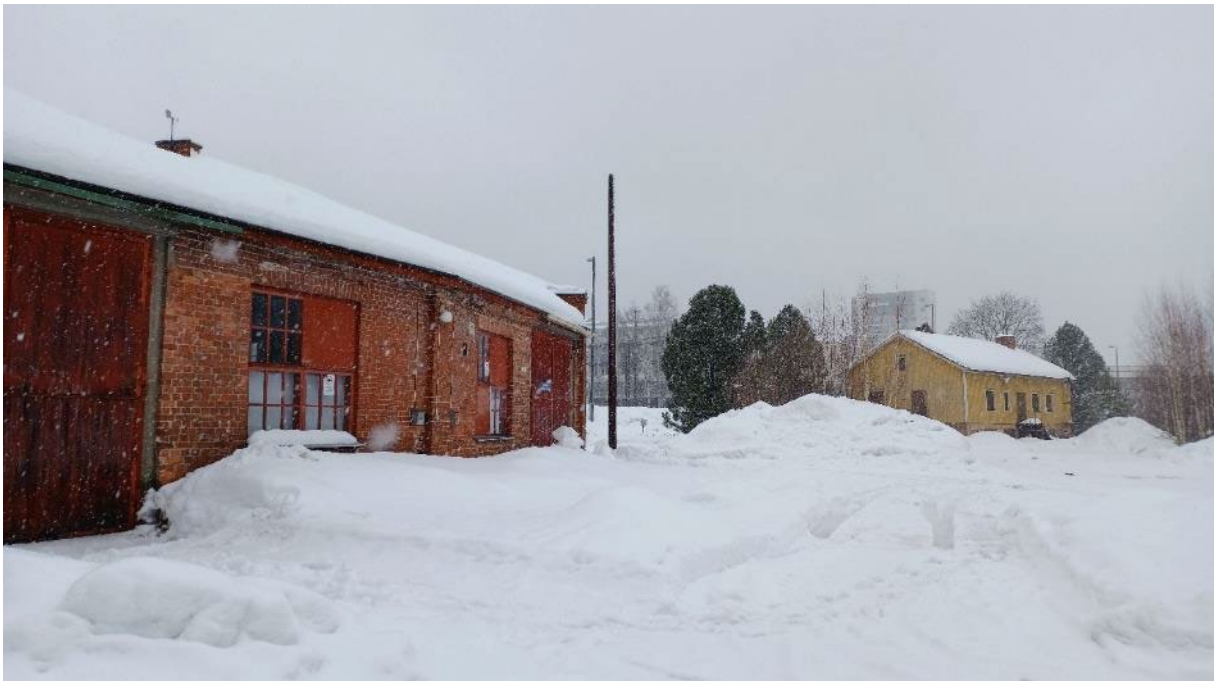
Kuva 31. Näkymä veturitallien ulkokaaren puolelta, Ratakadulta kohti pohjoista, jossa näkyy VR:n entinen huoltorakennus.
