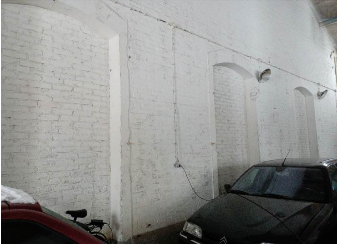
Kuva 106. Umpeen muurattuja oviaukkoja. Seinän takana on tila 3-4 eli petankkihalli. Seinällä näkyvät pyöreät valaisimet ovat alkuperäiset ja toimivat edelleen.
