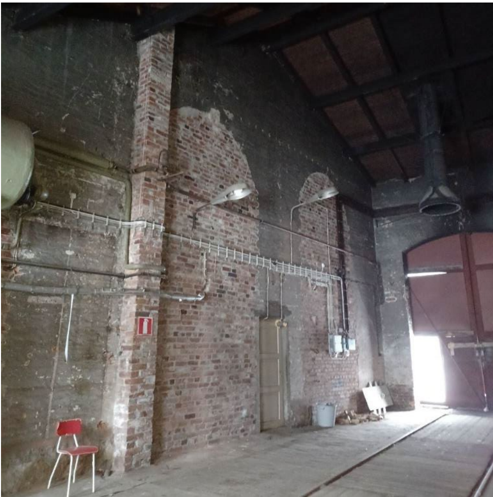
Kuva 76. Seinissä näkyy alkuperäinen aukotus. Alun perin tiiliseinät ovat olleet kalkatut. Maalipinta on noesta tummunut.
