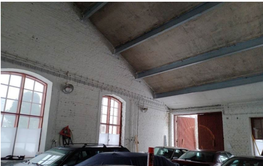
Kuva 107. Näkymä rakennuksen pohjoispäädystä kohti ovea 11.
