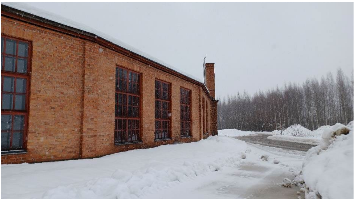
Kuva 29. Näkymä Ratakadulle koillisen suuntaan, jossa näkyy kahden pistoraitteen ylityskohta. Kuvassa rakennuksen uusinta osaa, laajennettua ulkokaarta.
